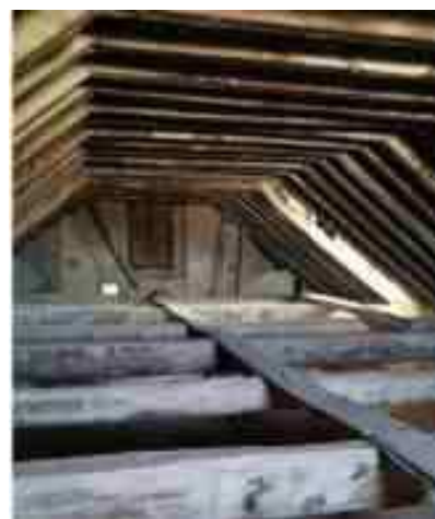
Restos del antiguo coro en el falso techo
