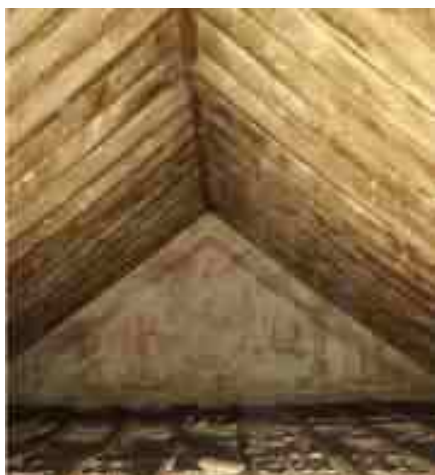
Pinturas ocultas en el falso techo
