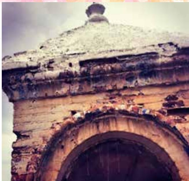
Ilustración 2: Estado actual de uno de los lucernarios del depósito de agua.
