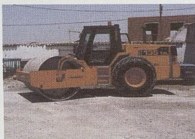
Explanaciones y compactaciones
